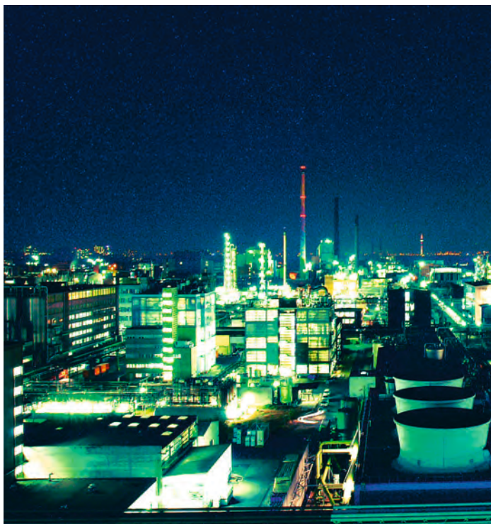
Reference: Industrial area Höchst, Frankfurt © 2004 Infracore GmbH & Co. Höchst KG
